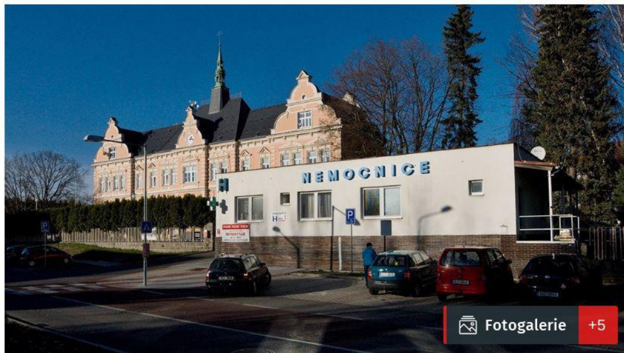
Nemocnice Frýdlant | foto: Ota Bartovský, MAFRA
